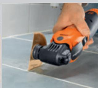
Dépose de joints très étroits avec une lame à concrétion carbure de 1,2 mm de largeur.
