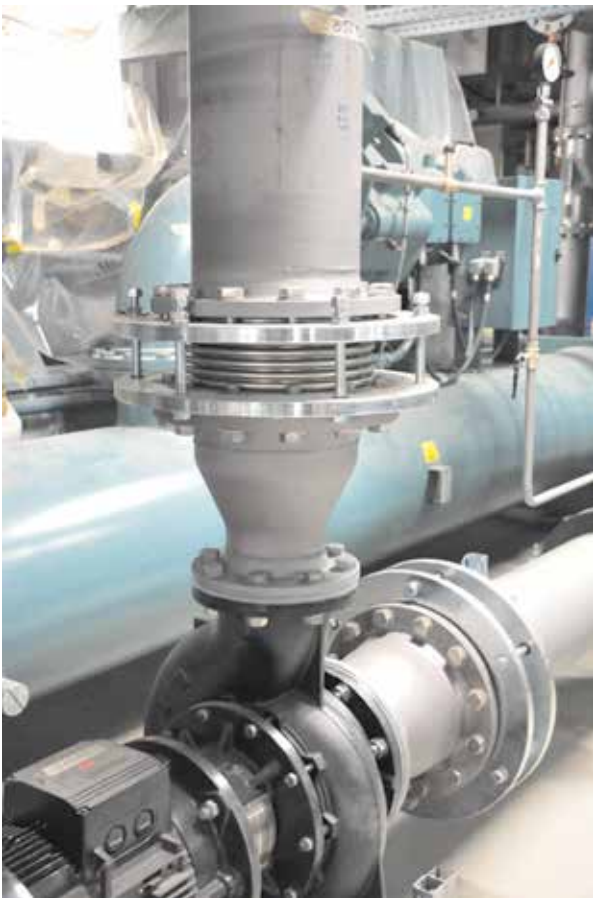
Kühlsystem / Krankenhaus-Schweiz Schwingungsdämpfer DN300 / PN16
