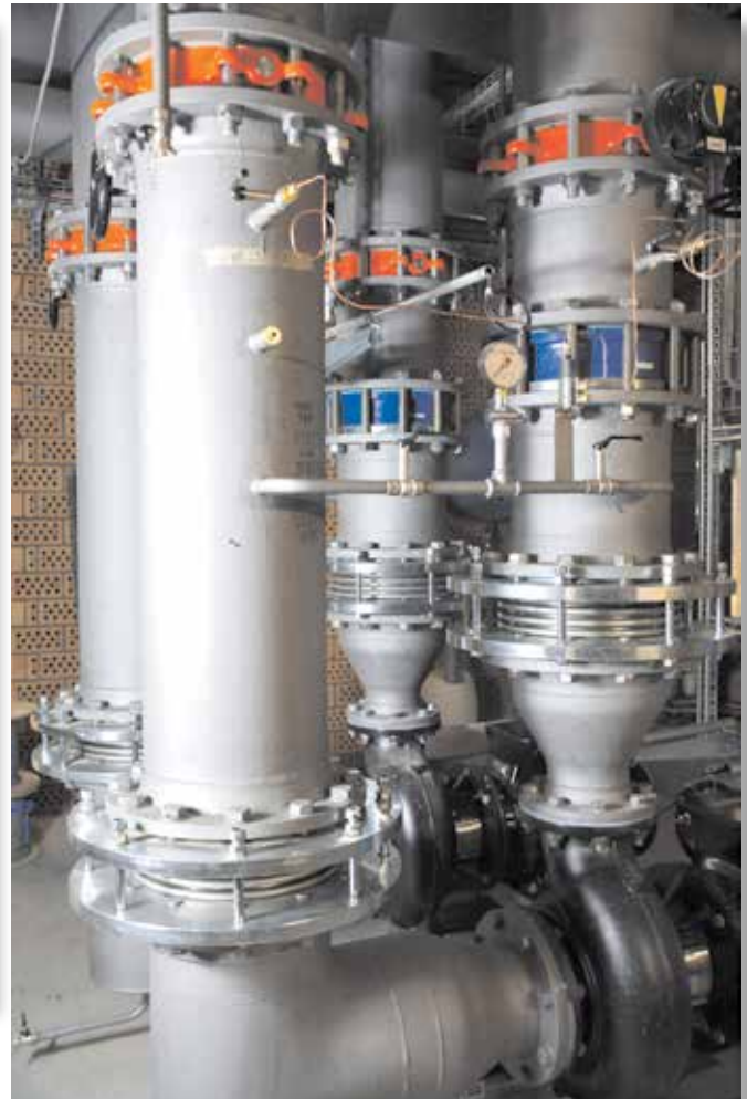
Système de refroidissement / Centre hospitalier Suisse DN300 / PN16 amortisseurs de vibrations
