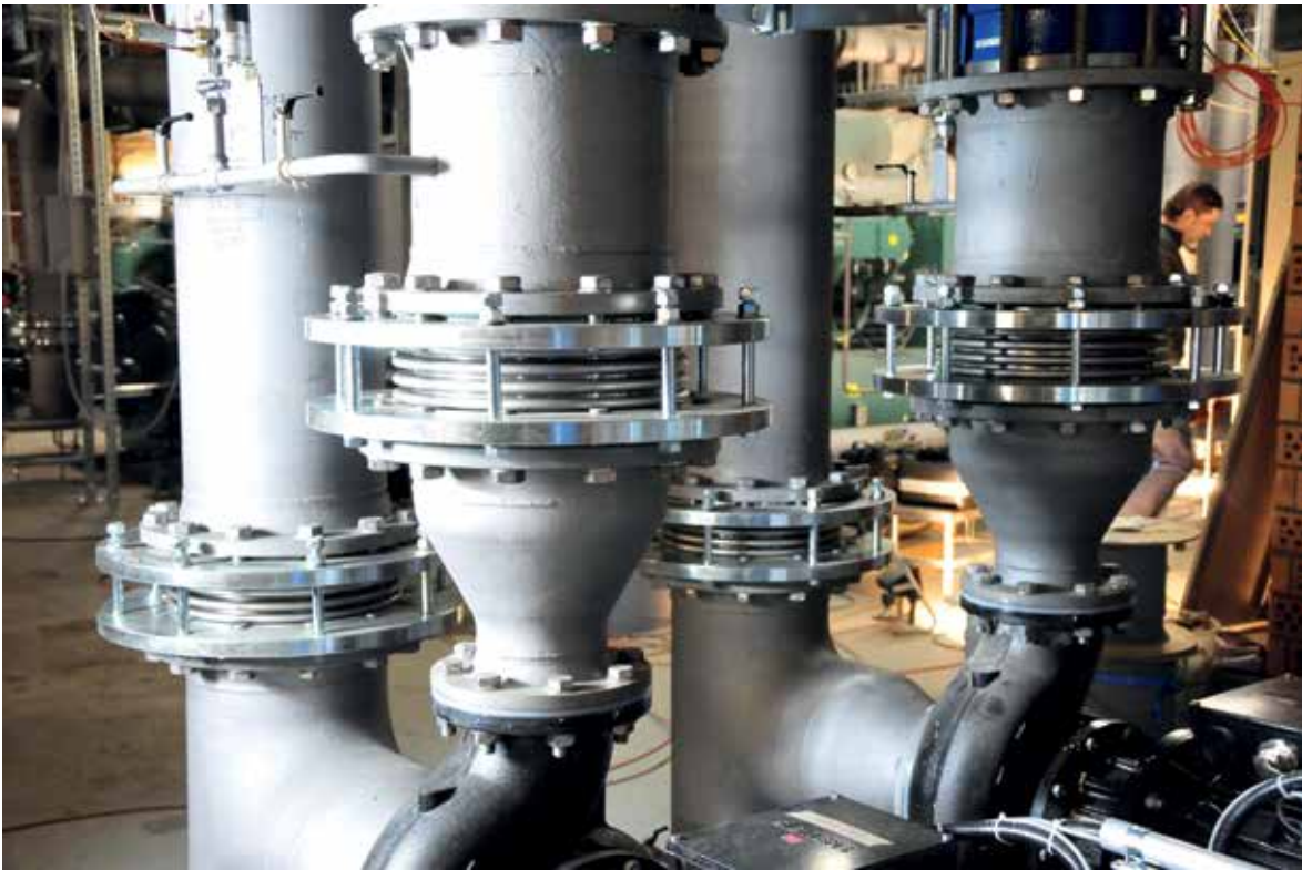
Kühlsystem / Krankenhaus-Schweiz Schwingungsdämpfer DN300 / PN16
