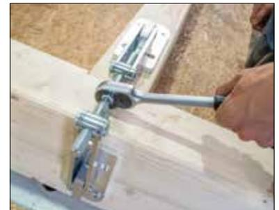
Permet d'éviter le risque de fissures et de fentes
